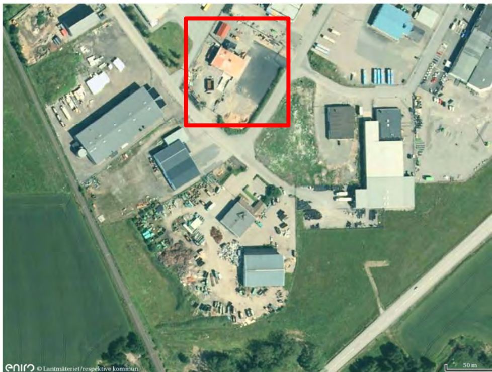
Figur 1 Värmecentral med pannhus och bränsleintag (inom röd ruta) i ett industriområde i södra Vara.
