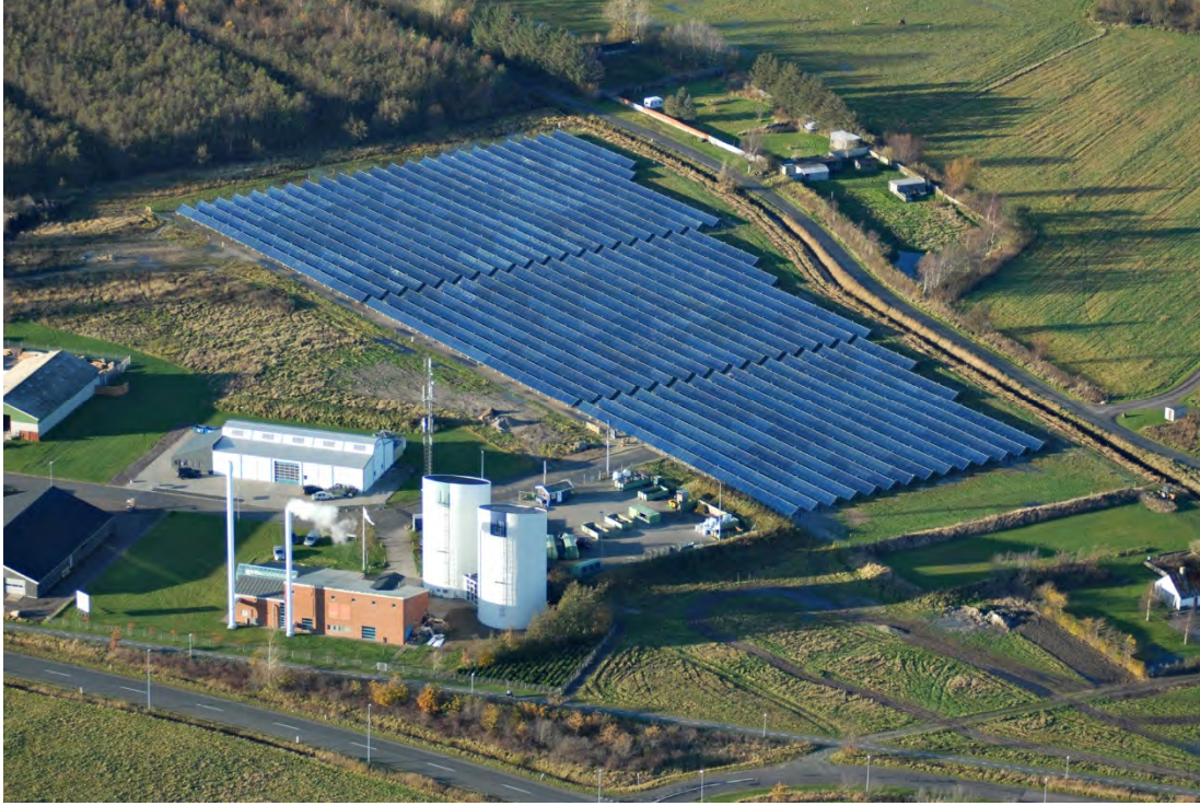
Bild: Strandby Varmeværk med 8 000 m 2 solfångare uppförd i Danmark 2008
