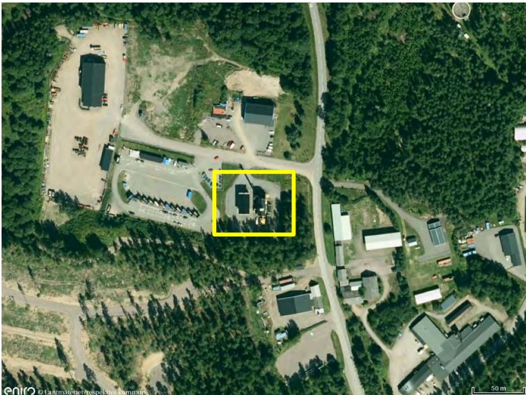
Figur 1 Värmecentral med pannhus och bränslelager på Erstorpsvägen nära den norra infarten från väg 34 till Borensberg.
